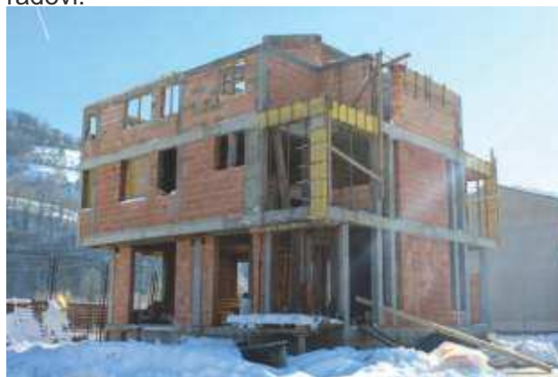
Izgradnja objekta u Trnovu
