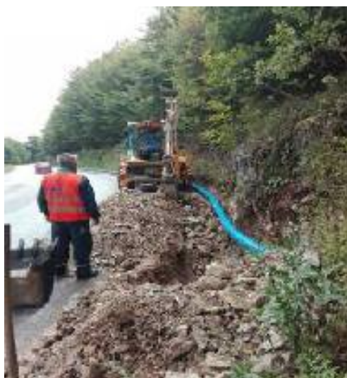
Slika 23. Izgradnja regionalnog vodovoda Velika Vrela - Hojta - Babin Do Izvor: Općina Trnovo
