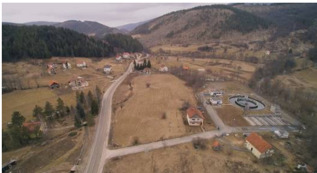
Slika 25. Postrojenje za tretman otpadnih voda u Trnovu Izvor: Općina Trnovo
