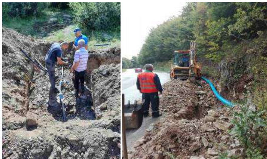
Slika 56. Izgradnja vodovoda Izvor: Općina Trnovo
